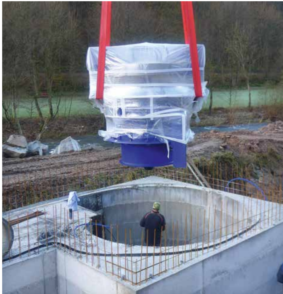
Anlieferung der Turbine
