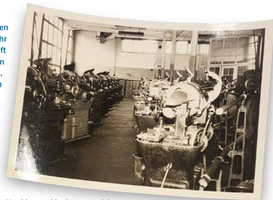
Maschinensaal in den 1950er Jahren
