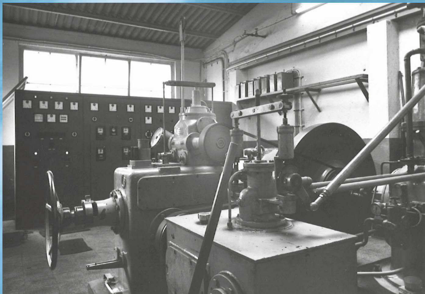
Turbinenhaus Ende der 1950er Jahre
