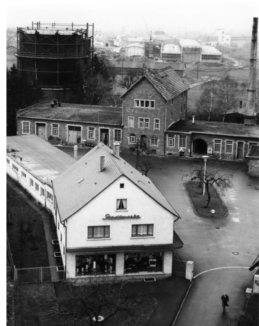
Neuer Werkhof der Stadtwerke im Rohackerweg, 1956
