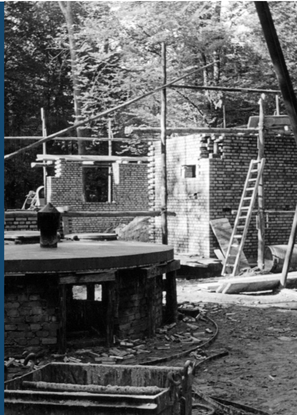
Grundwasserwerk Hardtwald im Bau, 1950
